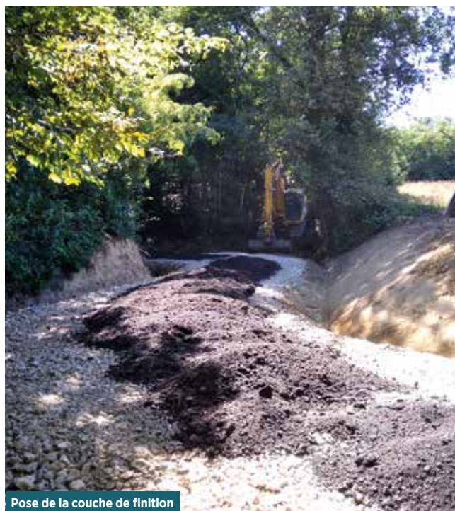
Pose de la couche de finition
